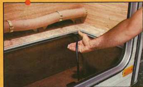
Detailproblem: Die Gummikeder einiger Kantenleisten lösen sich schon mal von selbst.
