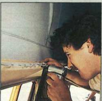
15. Ist die alte oder neue Liegefläche montiert, kann der Dachhimmel wieder an die Holzleisten des Dachausschnitts getackert werden.
